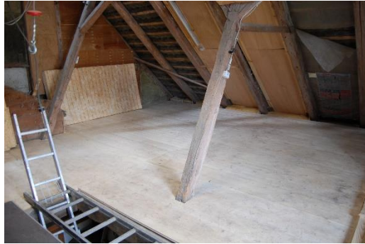
18) Bodenklappe eingebaut. ( Fa. Ernst )
