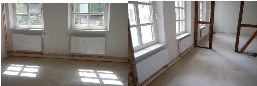
21) Malerarbeiten wurden abgeschlossen. ( Fa.Best. )
