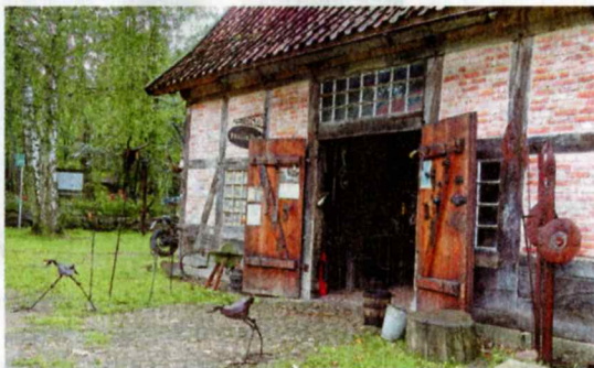
Die Schmiede im Museumsdorf nach ihrer Fertigstellung. Nun erhielt sie auch ein Vordach Foto: MGW
